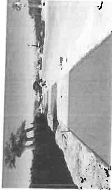
**CONSTRUCCION DE BANQUETA DE 10 CMS DE ESPESOR, DE CONCRETO PREMEZCLADO F'C= 180 KG/CM<sup>2</sup> HECHO EN OBRA, INCLUYE: AFINE DEL TERRENO, JUNTA FRIA CON CELOTEX A CADA 3.0 MTS Y CORTE CON DISCO A CADA 1.50 METROS, CIMBRADO Y DESCIMBRADO, HERRAMIENTA Y MANO DE OBRA.**
